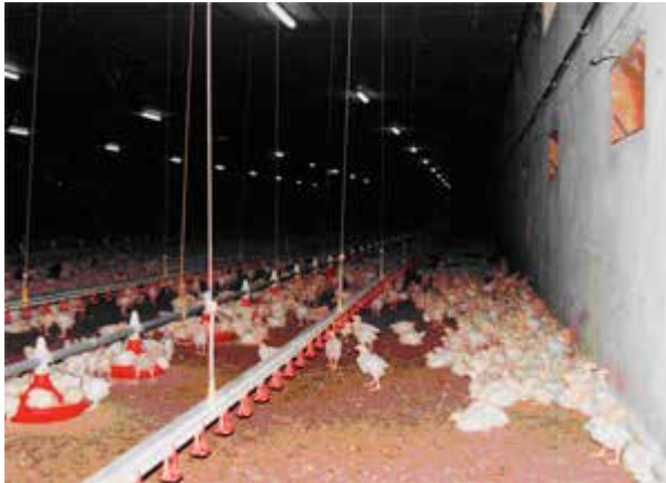
Abb. 1: Zwangsgelüfteter Maststall mit höhenverstellbaren Versorgungseinrichtungen (Foto: Gartung)
