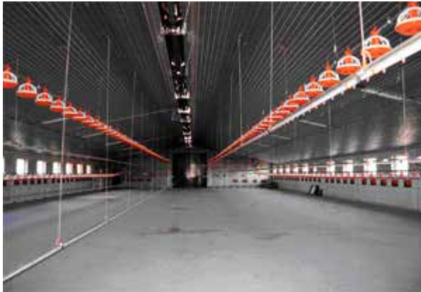
Abb. 3: Blick in einen konventionellen Hähnchenmaststall während der Reinigung. Futter- und Tränkelinien, Dunkelstrahler unter dem First, Öffnungsventile an den Längswänden (Foto: Gartung)
