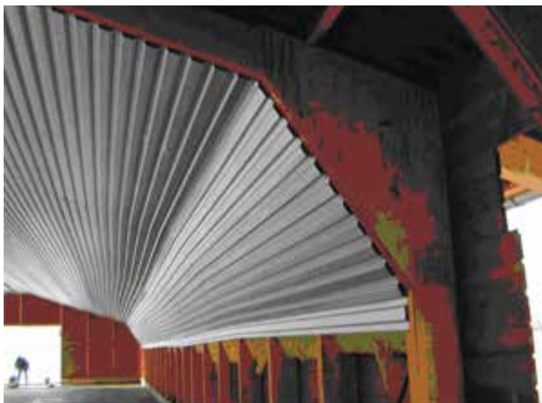
Abb. 2: Rahmenecke an der Traufe. Stiel und Riegel sind stumpf gestoßen und durch Sperrholz miteinander verbunden (Foto: Gartung)
