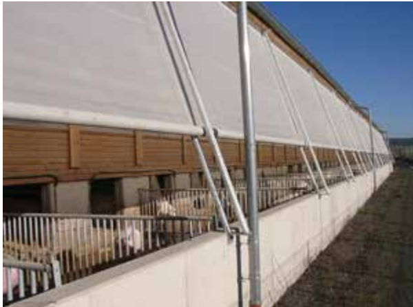
Abb. 2: Auslauf für Mastschweine mit motorgetriebenen Rollos als Sonnenschutz (Foto: Fritzsche)
