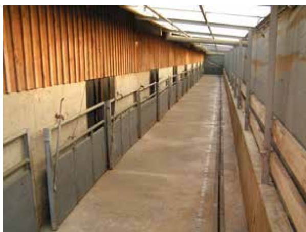
Abb. 1: Plan befestigter Auslauf im Abferkelbereich mit einer funktionssicheren Jaucherinne, schwenkbaren Buchtenabtrennungen und Überdachung (Foto: Fritzsche)
