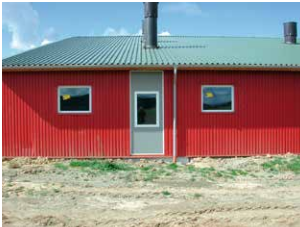
Abb. 2: Das hellgraue Wandteil kann im Notfall von der Feuerwehr von außen geöffnet werden und so einen zweiten Rettungsweg zu den Tieren ermöglichen (Foto: NLG)
