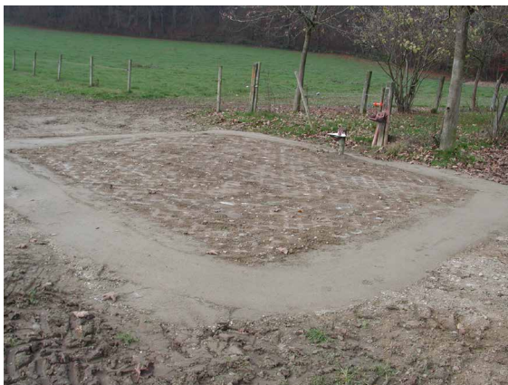
Abb. 15: Großräumige Befestigung eines Wassertränkeplatzes mit Rasengitterelementen (© LAZBW)
