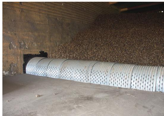
Abb. 5: Quer zur Einlagerungsrichtung angeordneter Oberflurkanal zur Luftverteilung im Kartoffelstapel (© Peters)
