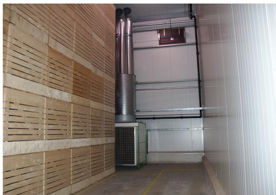
Abb. 6: Raumbelüftung von offenen Großkisten über eine Mischlufteinheit (© Peters)
