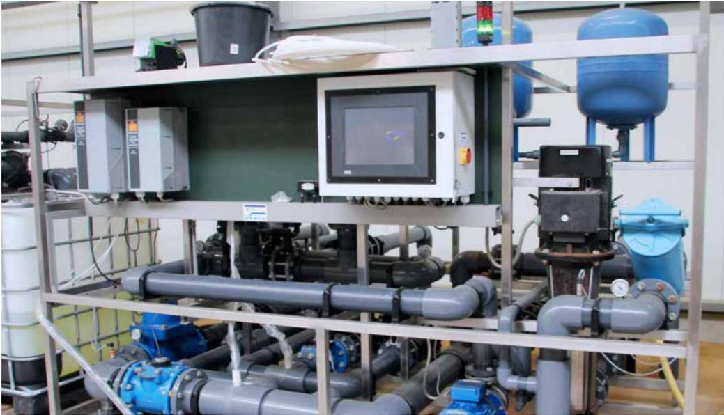
Abb. 3: Fest installierte Düngerdosiereinrichtung zum Mischen von schwach konzentrierten Gebrauchslösungen (© C. Reinhold)
