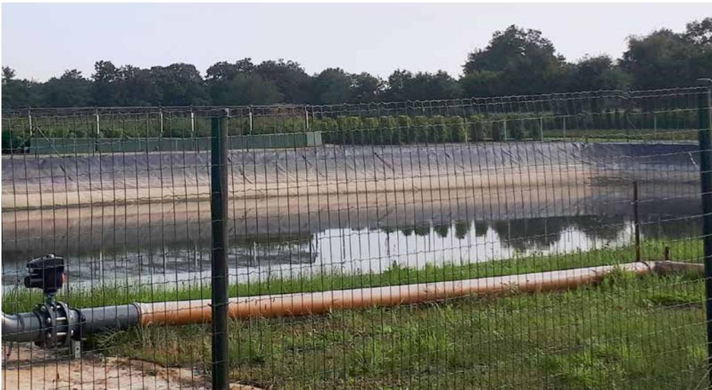
Abb. 2: Speicherteich mit Folienauskleidung (© T. Belau)
