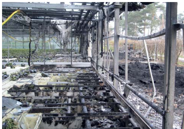
Abb. 3: Schaden durch in Brand geratenes, am Gewächshaus vorgelagertes Verpackungsmaterial. – Dank B 1-Schirm konnte sich das Feuer nicht weiter ausbreiten
