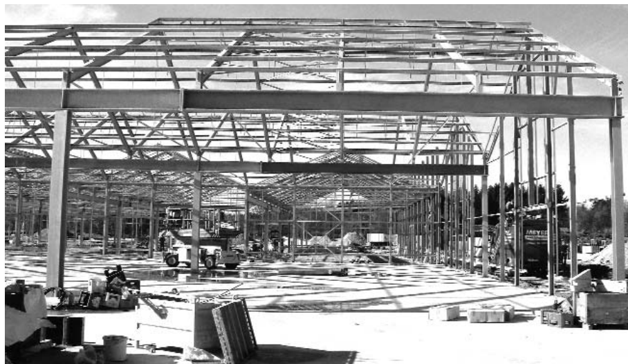
Verkaufsgewächshaus in der Bauphase.
