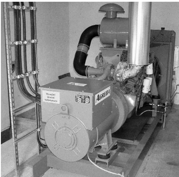
Abb. 1: 300-kVA-Ersatzstromaggregat
