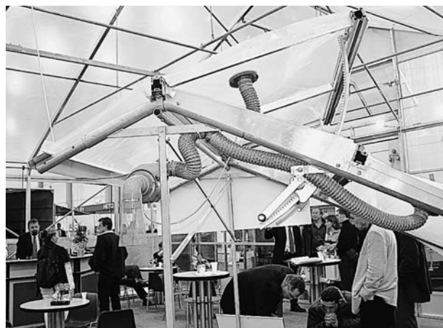
Abb. 7: Durchgehende Firstlüftung mit aufgeblasener Doppelfolie Fotos (3): Haas
