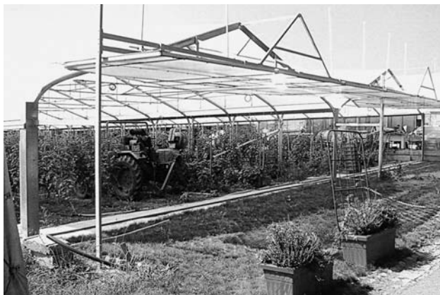
Abb. 5: Folienhauskonstruktion mit automatisch zu öffnendem Giebel Werkbild: Krötzel
