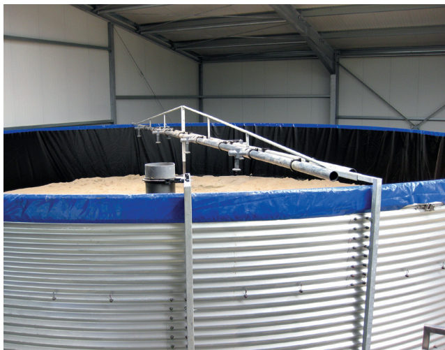
Abb. 4: Langsamfilter aus Stahlwellblechbehältern (Foto: Wohanka)
