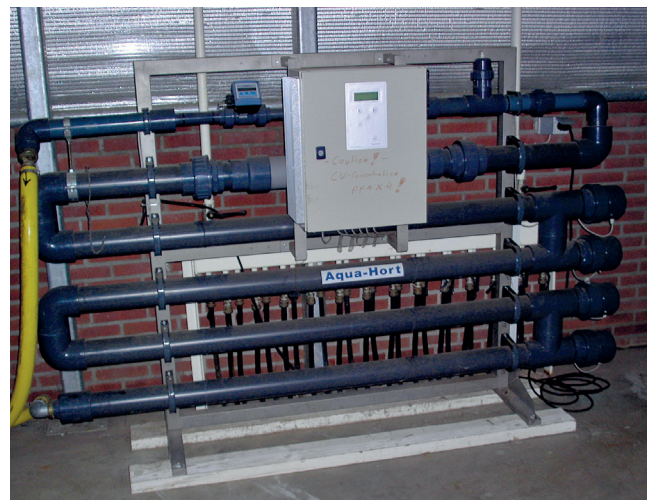
Abb. 11: Gerät zur Kupferionisierung von Gießwasser (Foto: Wohanka)
