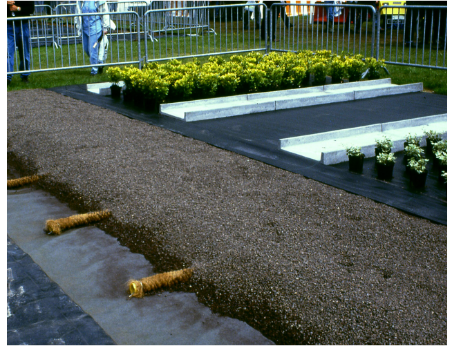
Abb. 5: Modell einer Containerkulturfläche mit Drainageschicht aus Lava (Foto: Beltz)
