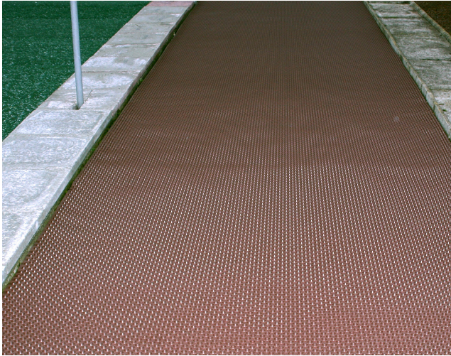
Abb. 6: Drainmatte vor der Abdeckung mit Bändchengewebe (Foto: Beltz)
