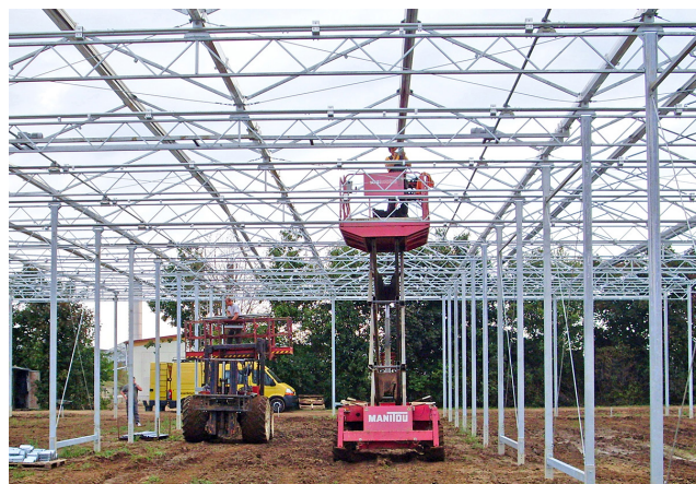
Cabriogewächshaus in der Bauphase (Foto: VDH Foliekassen BV, Hazerswoude-Dorp)
