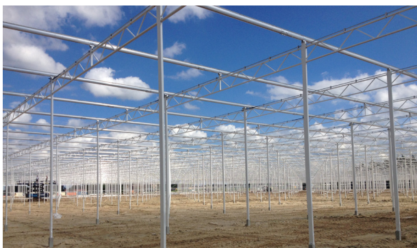
Venlogewächshaus in der Bauphase (Foto: Gakon Horticultural Projects, Wateringen)
