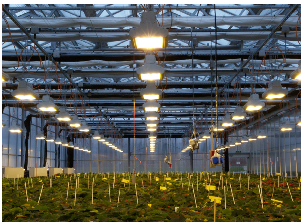
Abb. 1: Assimilationsbelichtung bei einsetzender Dämmerung (Quelle: Fa. DHLicht 2012)
