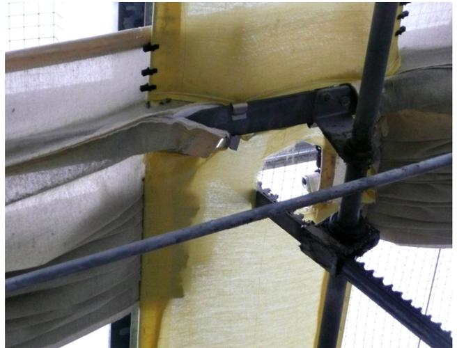
Abb. 8: Kaputte und schlecht installierte Energieschirme lassen Wärme durch (Quelle: Kirchner)
