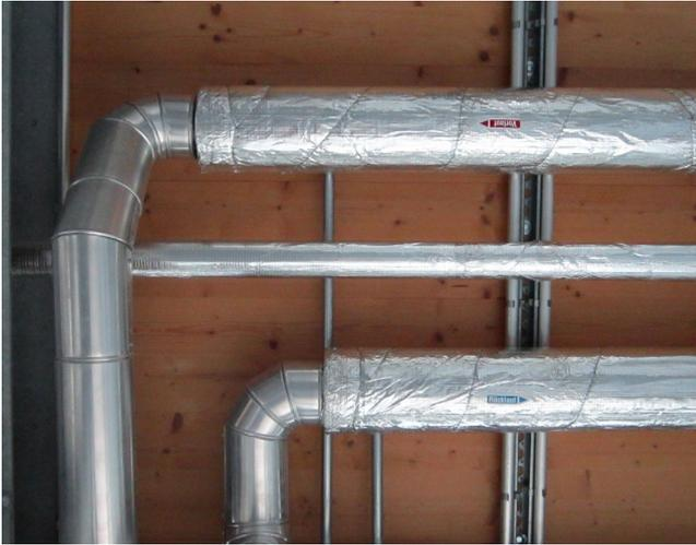
Abb. 4: Isolierte Verteilerrohre bringen die Wärme zum Ort des Bedarfs (Quelle: Schwittek)
