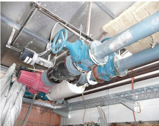
Abb. 5: Eine schlechte Isolierung führt zu hohen Energieverlusten (Quelle: Kirchner)
