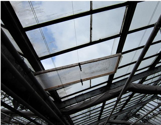
Abb. 2: Verschmutzte und verrutschte Scheiben verringern die Lichtausbeute und führen zu hohen Wärmeverlusten (Quelle: Schwittek)
