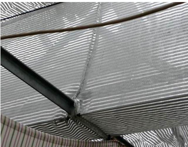
Abb. 7: Energieschirme müssen auch an Übergängen dicht schließen (Quelle: Kirchner)
