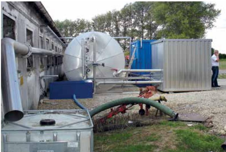
Abb. 1: Containerbasierte Pilotanlage mit liegendem Fermenter (Quelle: Weitze)
