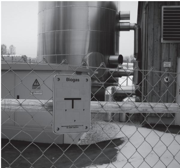
Abb. 3: Satelliten-BHKW an der Gärtnerei einer Justizvollzugsanstalt mit einem Warmwasser-Schichten-speicher von 30 m<sup>3</sup> und DVGW-konformer Ausführung der Biogasleitung (Foto: Baumann)
