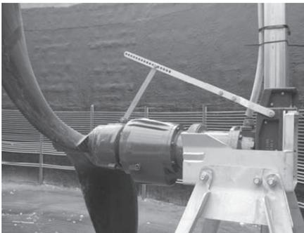
Abb. 3: Einsatz neuer langsam laufender Rührwerke
