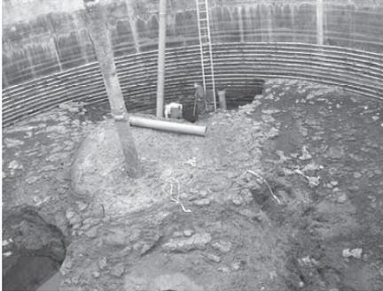
Abb. 1: Reinigung der Speicherdurchfluss-Fermenter
