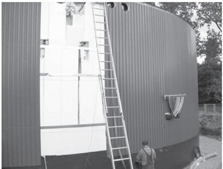
Abb. 4: Verstärkung der Behälterdämmung
