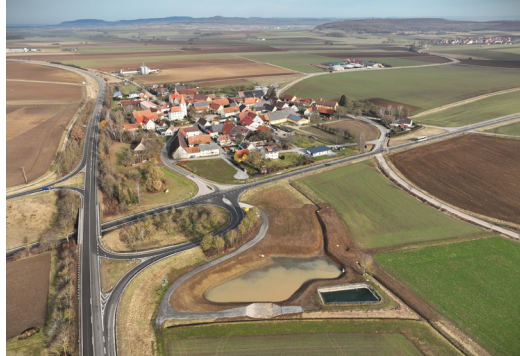
Abb. 3: Umgestaltete Teichkläranlage zum Wasserspeicher (© Wasserwirtschaftsamt Ansbach)
