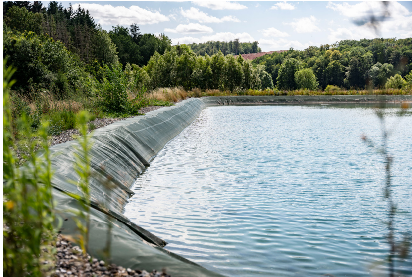
Abb. 6: Erdfolienbecken zur Befüllung bei ausreichendem Wasserdargebot während der Wintermonate sowie in niederschlagsreichen Jahren mit geringerem Bewässerungsbedarf (© ALB)
