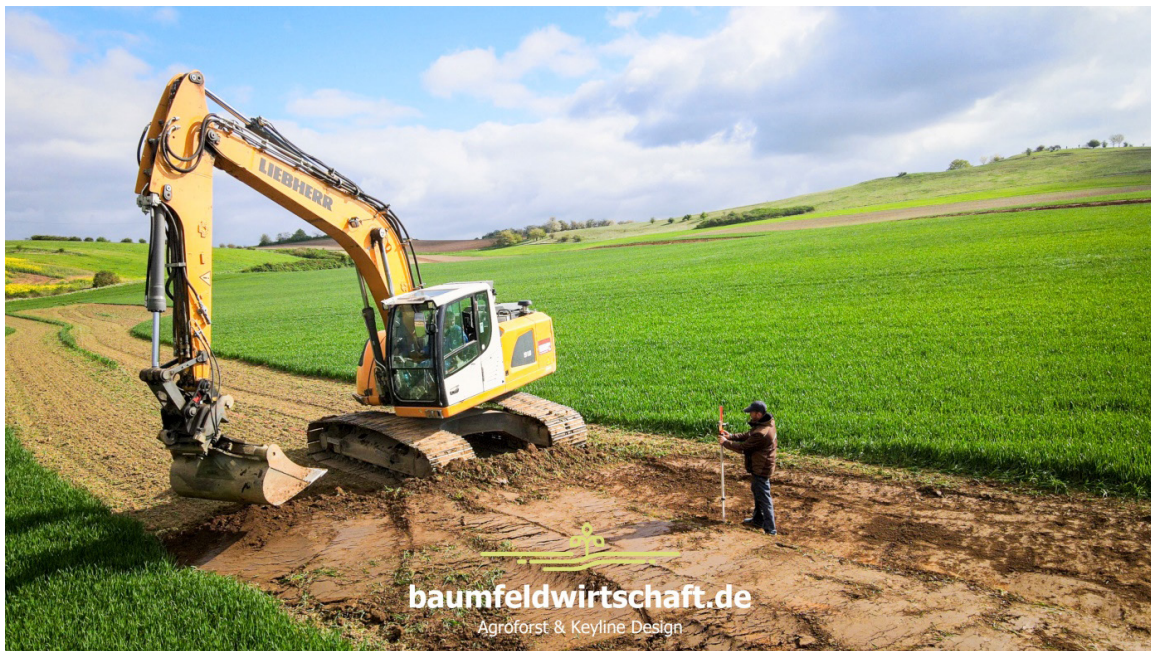
Abb. 2: Anlage von Verteil- und Sickergräben durch die Firma Baumfeldwirtschaft. Die Gräben fangen Oberflächenabflüsse auf und leiten sie auf die konvexe Geländeform, wo es vorher am trockensten war (© baumfeldwirtschaft.de).
