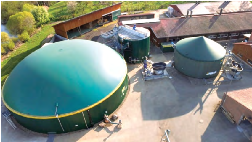
Abb. 1: Forschungsbiogasanlage des Fraunhofer IEE (mittlerer Fermenter), Nachgärer (links) und die Mutterbiogasanlage des LLH (rechts) am Standort Eichhof in Bad Hersfeld (© IEE)
