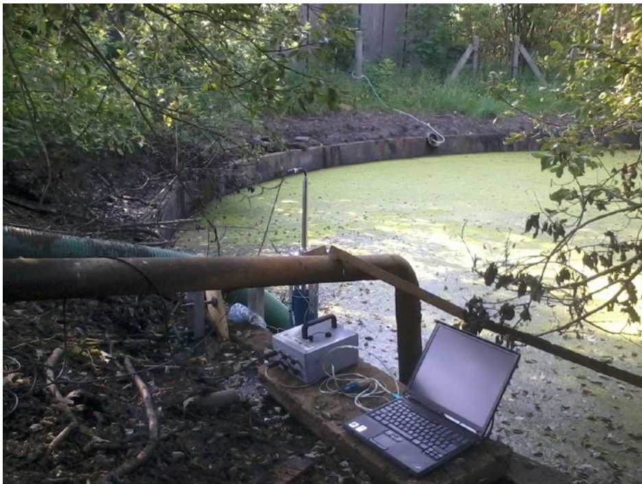
Abb. 2: Aufbau der Messeinrichtung (© APO Geopohl AG)
