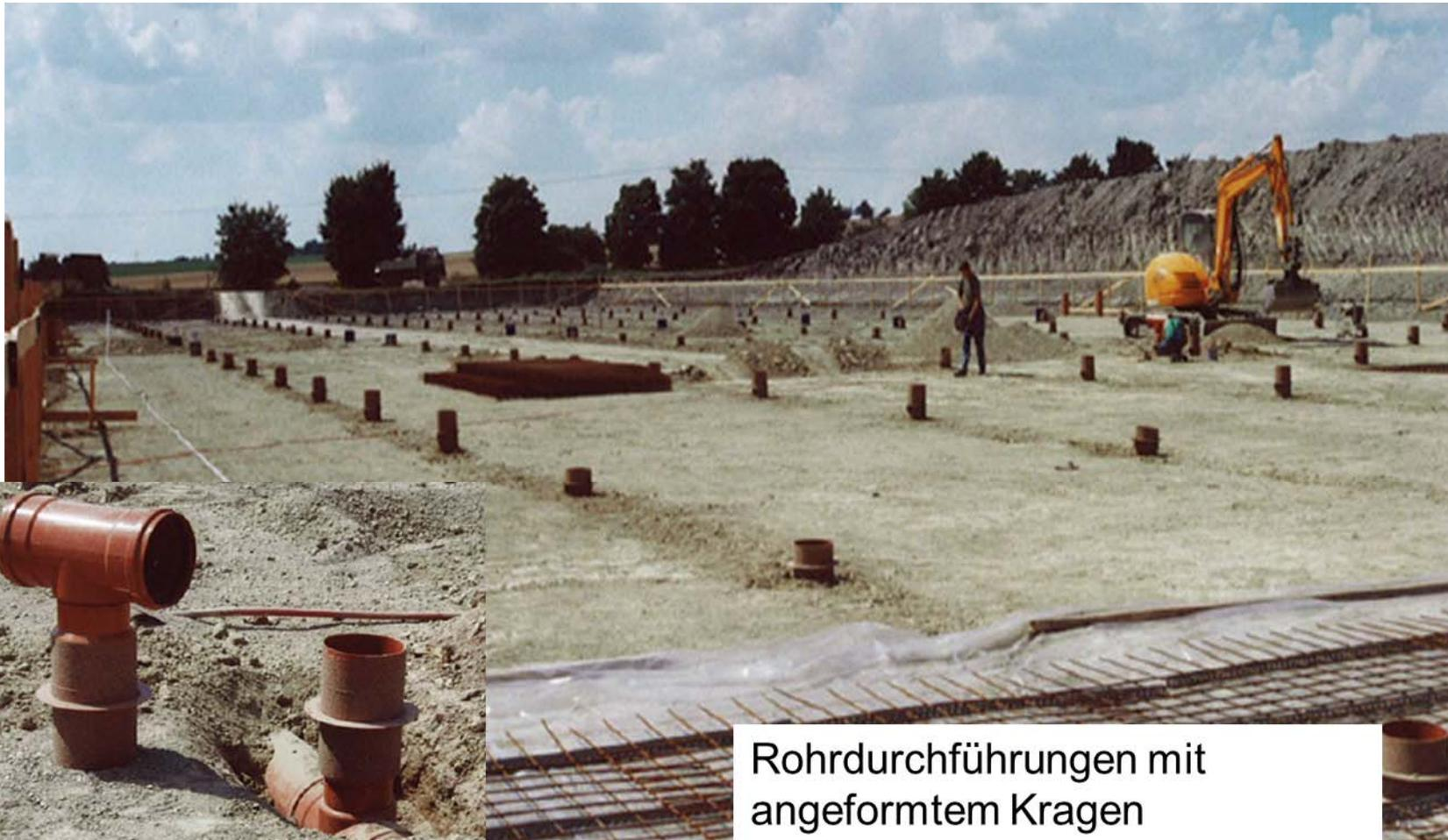
Rohrdurchführungen mit angeformtem Kragen
