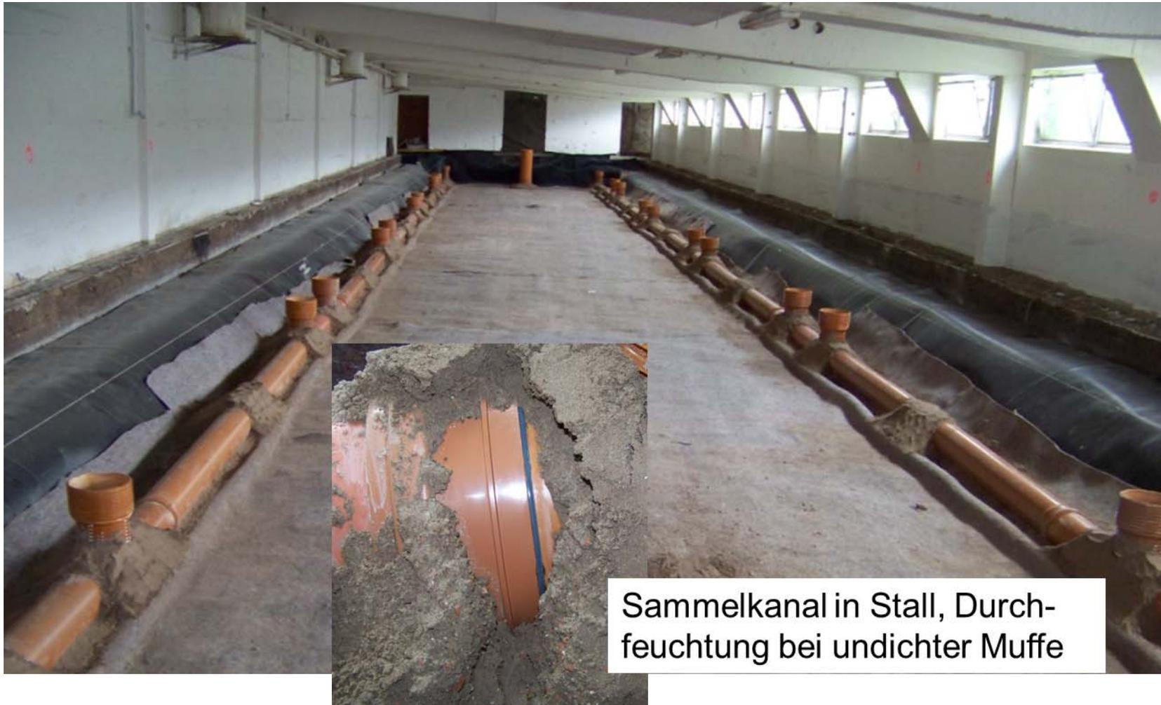
Sammelkanal in Stall, Durchfeuchtung bei undichter Muffe
