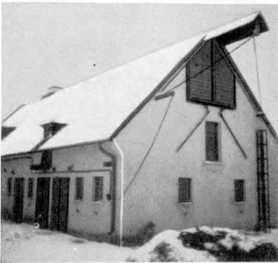
**Abb. 96.** Heubodenluke für den Aufzug an der Giebelseite bei Typ II. Links neben der Dachrinne Schalter für den Aufzug.
