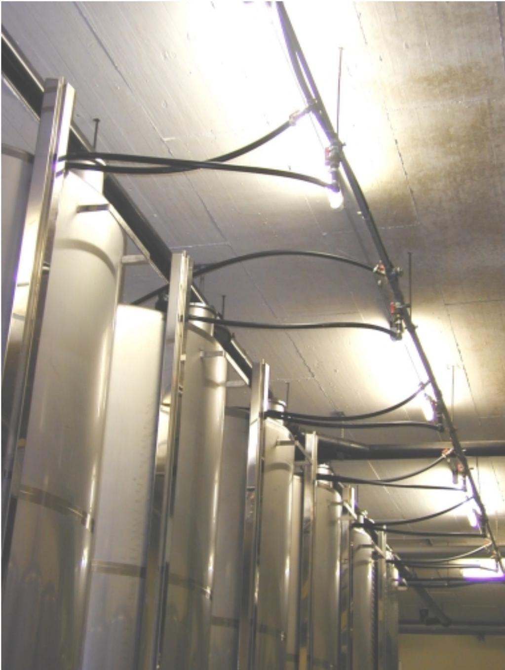
Abb. 30: Anschluss der Wärmeüberträgerplatten an den Kühlkreislauf
