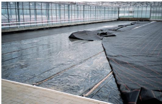
Abb. 26: In Vorbereitung befindlichen Ebbe-Flut-Folien-Boden mit noch nicht befestigtem Bändchengewebe (© O. Domke)
