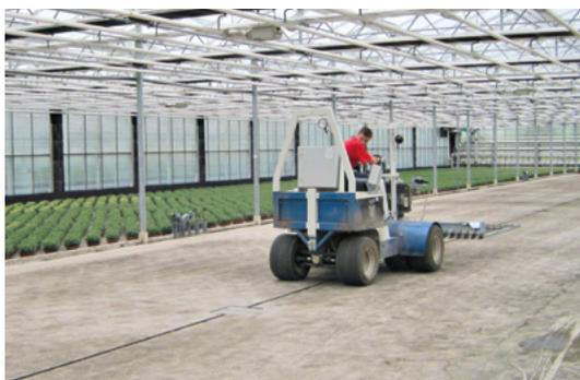
Abb. 25: Befahrbarer Ebbe-Flut-Beton-Boden zur Produktion von Zierpflanzen (© T. Belau)
