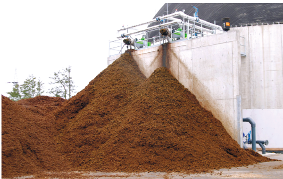
Abb. 6: Feststoffabscheidung einer Biogasanlage (© K. Möller)
