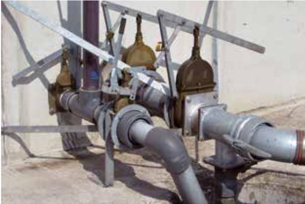
Abb. 1: Rohrdurchführungen der Behälterwand sind durch den Einbau von Schiebern zu sichern (Foto: Hackeschmidt)
