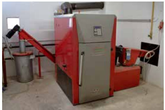
Abb. 2: Eine Hackschnitzelheizung kann mit unterschiedlichen Biomassebrennstoffen betrieben werden (Foto: © agrarfoto.com)
