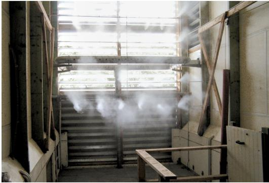
Abb. 7: Hochdruckvernebelung von Wasser im Vorraum zur Kühlung der Stallluft (Foto: Hackeschmidt)
