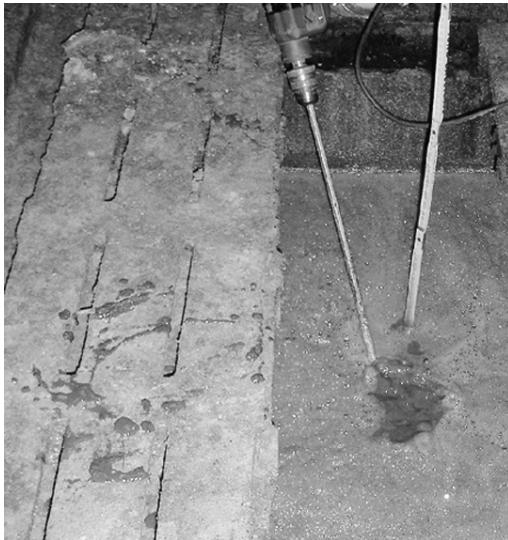
Abb. 2: Füllstandsmessung mittels Zollstock
