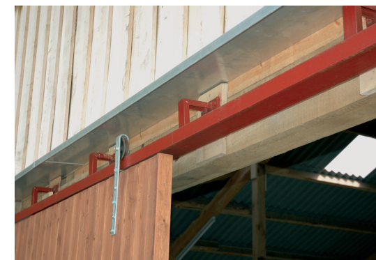
Eine Blechabdeckung schützt die Tore vor Niederschlägen
