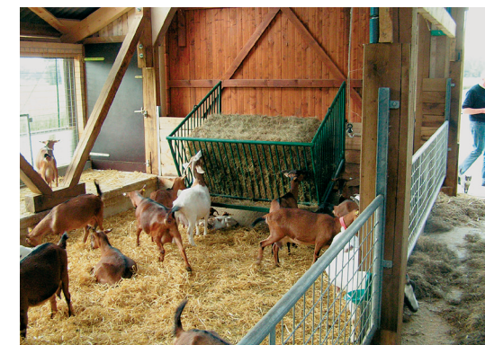
Die Heuraufen werden durch die Tore von außen befüllt und zum Entmisten einfach ausgehängt
