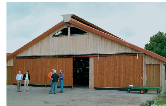
Durch Tore auf der Westseite sind der Futtertisch und die Buchten der Ziegen befahrbar
