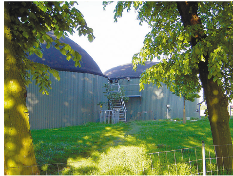
Bild 8: Biogasanlage der Familie Schulte Spechtel in Brienens, Kreis Kleve
