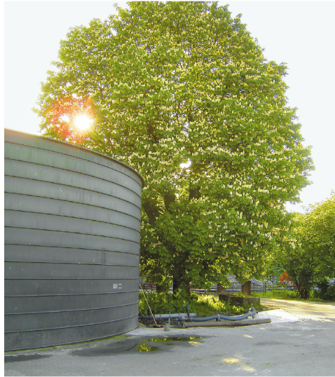
Bild 11: Gärrestlagerbehälter der Biogasanlage Bioenergie Schulte Spechtel
