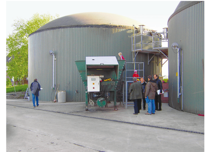
Bild 9: Feststoffeintragssystem mit Presskolben zur Einspeisung fester, stapelfähiger Substrate in den Fermenter (Bioenergie Schulte Spechtel)
