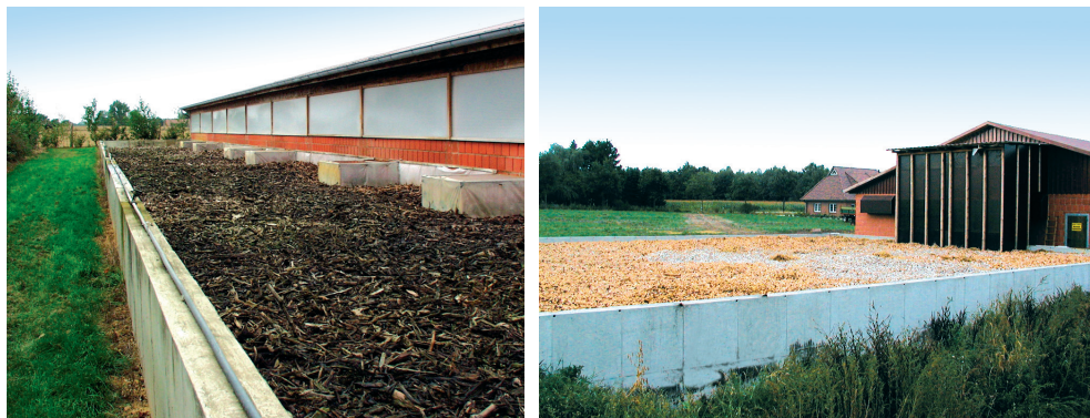
Abb. 2.1: Biofilter unterschiedlicher Bauweise (links: Wurzelholzschüttung, rechts: Strohbett mit Holzhackschnitzelaufgabe)
