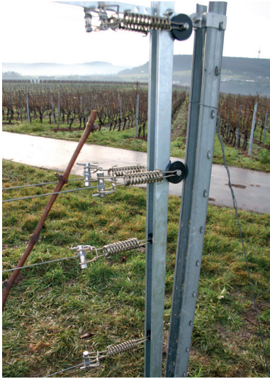
Abb. 14: Dynamik-System mit über Rollen verschiebbaren Spannfedern (© Walg)
