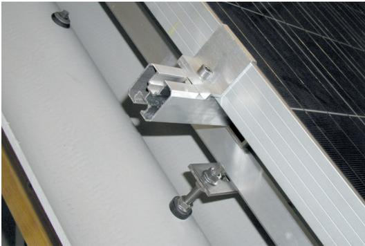
Abb. 25: Doppellagige Unterkonstruktion mit Stockschrauben zum Ausgleich von Dachunebenheiten (Quelle: Eggersglüß)
